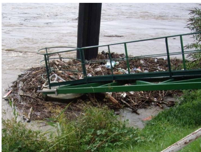
Objets flottants autour du détecteur d'hydrocarbures
